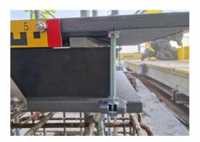
Während der Bauarbeiten musste der Verkehr weiterhin fließen können. Weil die neu errichteten Fahrspuren mit dem Bestandstragwerk verbunden werden, wurden alle Lager verschraubt ausgeführt und sind mittels Zwischenplatten höhenverstellbar sein.
