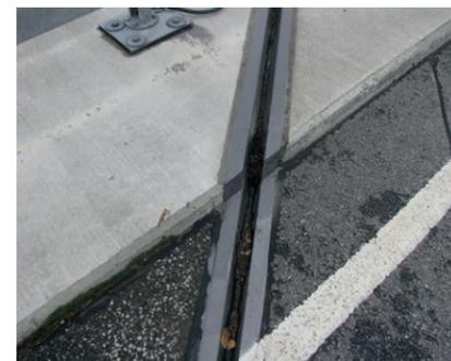
Oberflächenbündiges Stahlprofil im Gehweg
