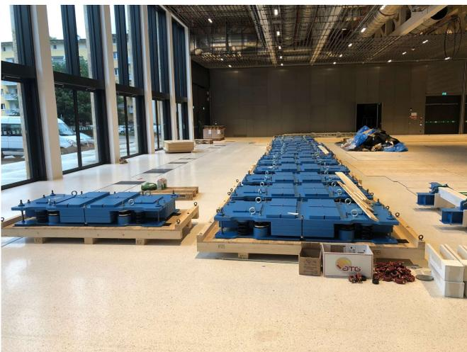
Durch die langjährige Erfahrung der Ingenieure bei SCHREIBER, konnten nicht nur die Schwingungen erheblich reduziert werden gleichzeitig wurden auch die Massedämpfer als Designelemente verwendet. Die 19 Massendämpfer welche ein Eigengewicht von bis zu 4,5 Tonnen besitzen, wurden so an der ersten Geschossdecke angebracht, dass jeder Besucher die Masse Dämpfer bei ihrer Arbeit sehen kann.
