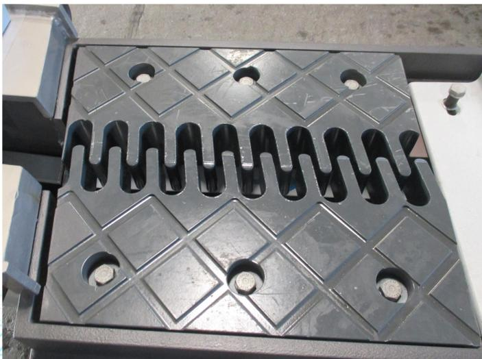
Die Hochstraßenbrücke führt die B9 bei Sinzig über mehrere innerörtliche Straßen im Bereich des Bahnhofs. Täglich passieren etwa 23.000 Fahrzeuge diesen Abschnitt und damit die von SCHREIBER gefertigten und installierten Fahrbahnübergänge.
